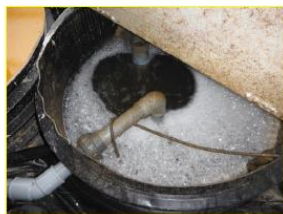
活性汚泥処理とミニ人工湿地の組合せ(別海町の例)
