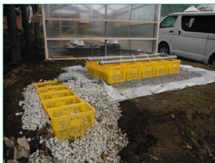
活性汚泥処理とミニ人工湿地の組合せ(別海町の例)
