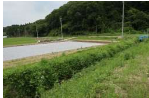
写真 5 楳田地区浸透式人工湿地
